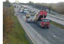
高速公路交叉道 - 勃兰登堡 德国 质量检测
