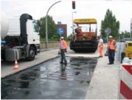
汉堡海港大桥路面利用反应树脂填充多孔沥青施工现场。
