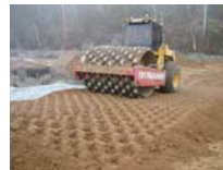
道路整治 Golm - 德国 施工中质量检测
