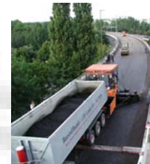
桥面沥青铺设
